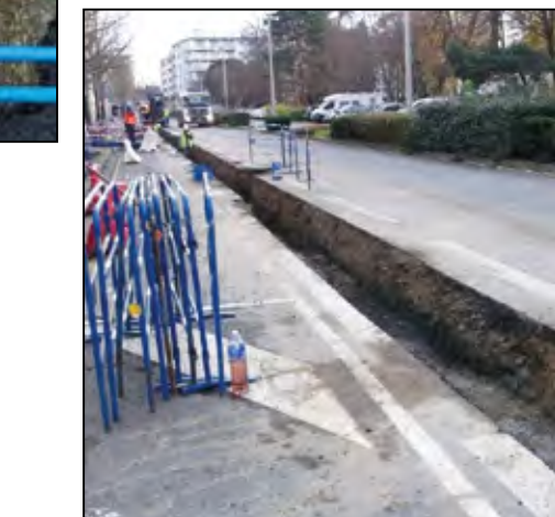
TARBES - Promenade du Pradeau (124 000 € HT) Travaux de renouvellement de réseaux d'eau potable conformément au schéma directeur pour remplacement des réseaux critiques.
