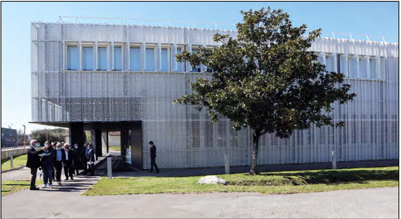
Nouveau bâtiment IUT Génie Civil
