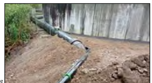
Après travaux - nouvelle conduite
