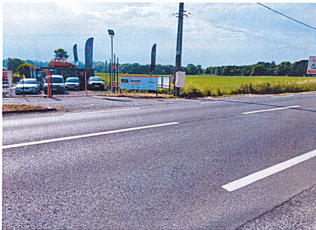
Vue de la propriété depuis la RD n° 935
