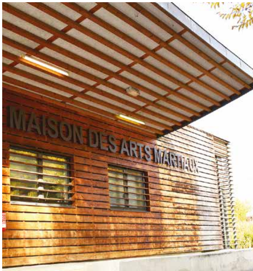
36 500 € sont inscrits pour des travaux sur la Maison des Arts Martiaux (sécurité, accessibilité...)
