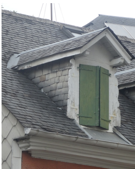
Lucarnes en bâtière, montants en bois à ailerons.
