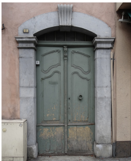
Arc cintré clef dépassante. Porte à vantail double, panneaux de bois sculptés.
