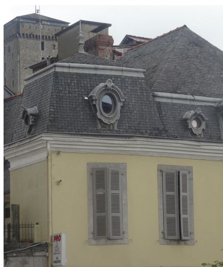
Toit à la Mansart, lucarnes et oculi en zinc
