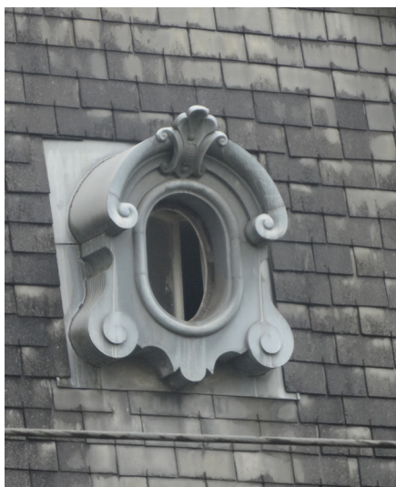
L'oculus en zinc sur le brisis du toit en ardoise.
