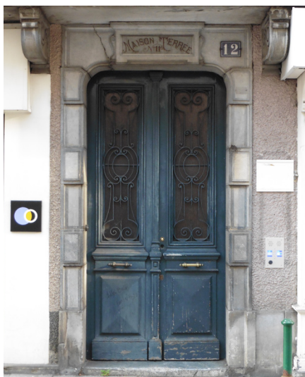
Porte à vantail double, panneaux de bois pleins et vitrés, grille de protection en fer forgé.
