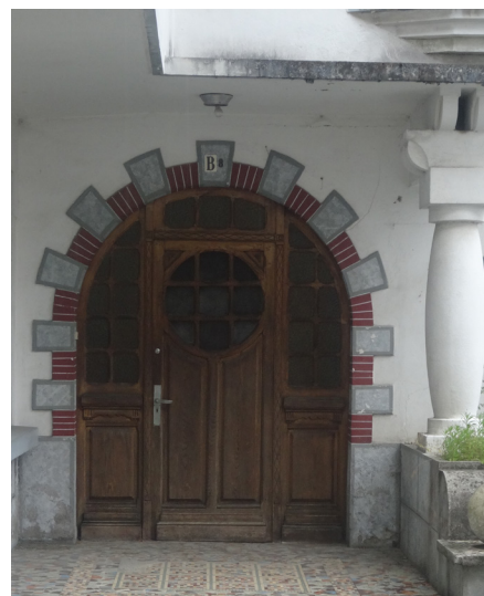
Porche d'entrée détail de colonne en béton moulé, porte à arc outrepassé, détail polychrome pierre et brique. Menuiserie en bois.
