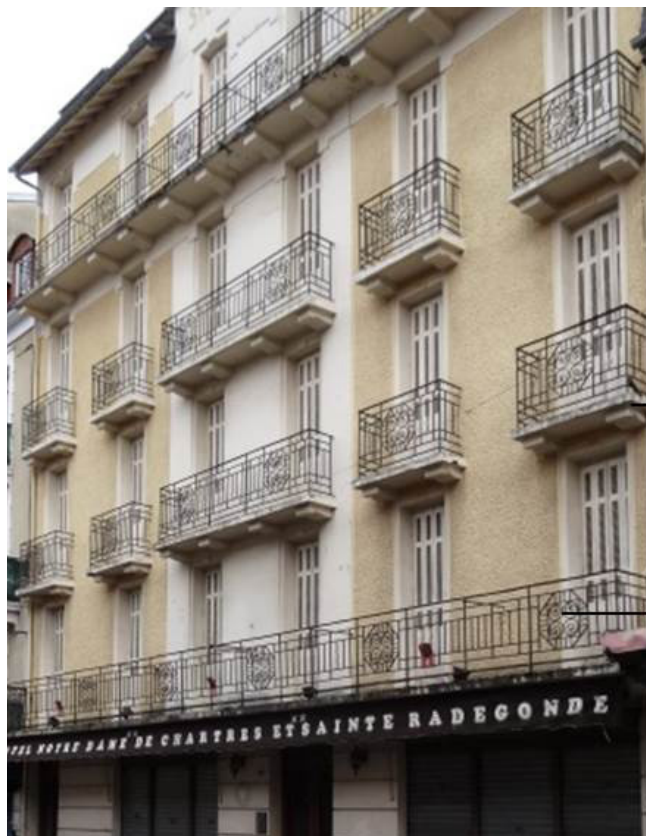
Balconnet sur console en béton
