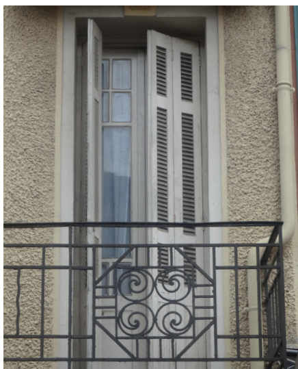
Porte-fenêtre, partition du vitrage type années 1930, volets pliants en bois persiennés, balcon ferronnerie à motifs Art-déco.
