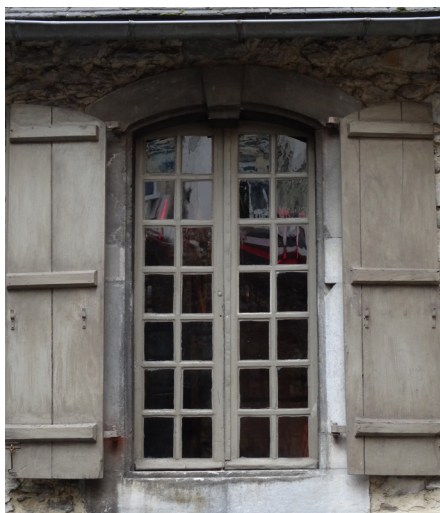
Fenêtre type XVIII e siècle, linteau incurvé, partition du vitrage à petits carreaux, contrevents en bois plein montés sur barres.
