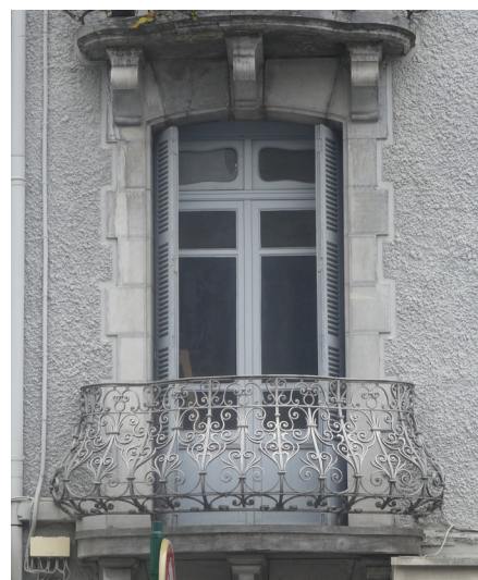
Porte fenêtrée, volets en bois pliants persiennés, balcon à galbe en fer forgé reposant sur consoles de pierres.
