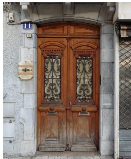
Encadrement arc surbaissé en pierre, porte à vantail double, panneaux de bois, grille de protection en fer forgé, serrurerie.
