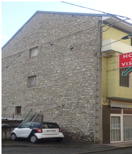
Construction récente (2 e moitié du XX e siècle) moellons de pierre hourdés, planchers et dalles en blocs béton.
