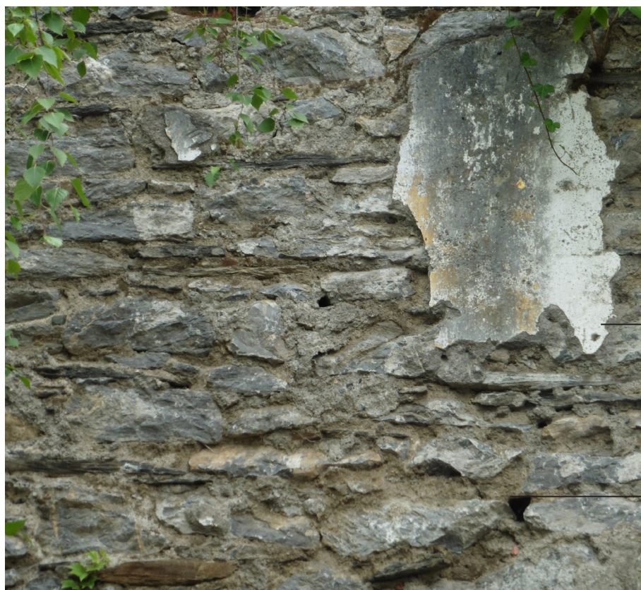
Enduit de protection
