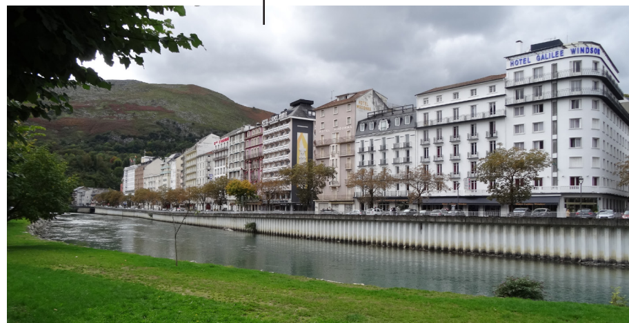
Le front bâti renouvelé sur l'avenue Peyramale.
