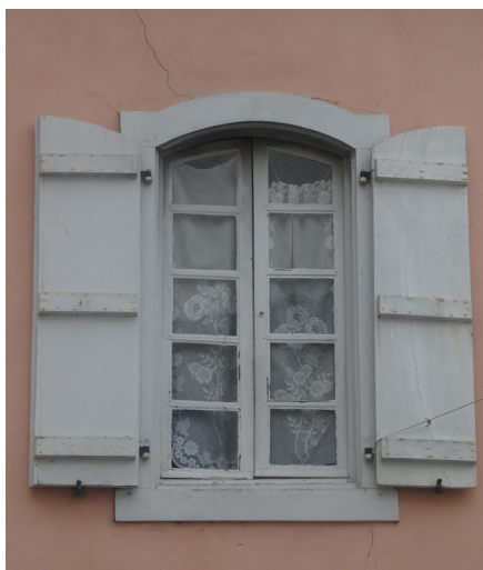
Fenêtre à linteau incurvé, en bois, partition du vitrage à petits carreaux, contrevents en bois plein montés sur barres.
