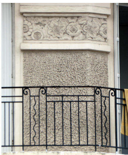
Façade Art-déco, détail des enduits à grain et lissés lisses, frise en ciment moulé à motifs floraux.
