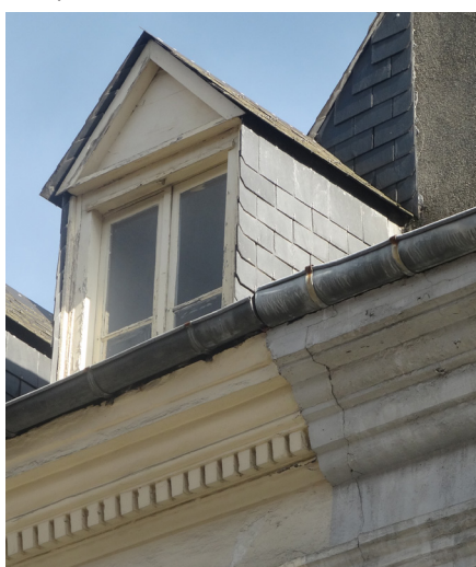
Corniches moulurées et denticules à gauche. Lucarne en bâtière simple en bois.
