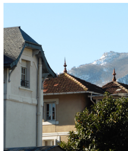
Toit à faible pente en tuiles de Marseille sur des villas
