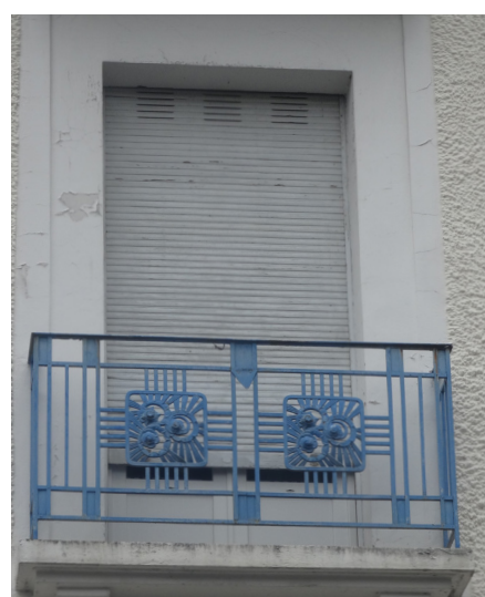
Porte-fenêtre, volets roulants en bois, encadrement et modénature béton moulé, balcon ferronnerie à motifs Art-déco.
