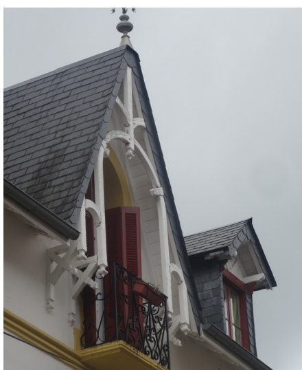
Lucarne passante, formant un fronton, détails et décors en bois peint.
