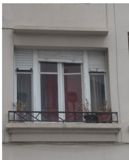
Porte-fenêtre, volets pliants en bois, encadrement et modénature béton moulé, balcon ferronnerie à motifs Art-déco.
